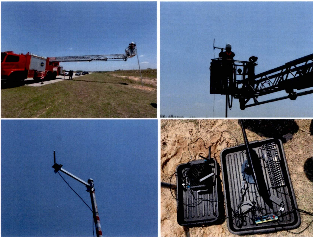
รูปแสดงการติดตั้งอุปกรณ์ในพื้นที่โครงการ
